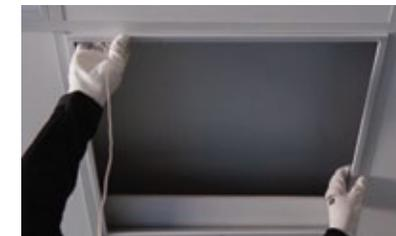
2. W miejsce kasetonu włóż panel ramkowy/Insert the LED FRAME Panel in place of the coffer/Insérer le panneau LED FRAME à la place du coffre/Setzen Sie das LED Rahmen Panel anstelle der Kassette ein
