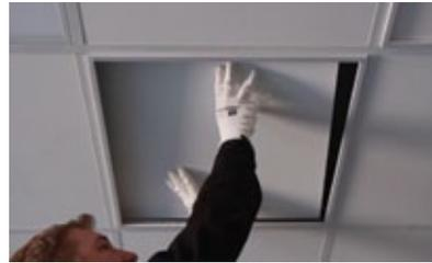
8. Włóż kaseton do stelażu/Put the coffer back in the ceiling frame/Remettez le coffre dans le cadre du plafond/Stellen Sie die Kassette in den Decke-Rahmen zurück
