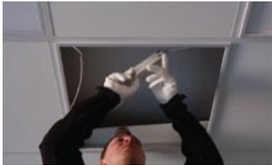
7. Ukryj zasilacz w suficie podwieszanym/Hide the LED driver in the coffered ceiling/Masquer le pilote LED dans le plafond à caissons/Verbergen Sie das LED-Netzteil in der verwharten Kassettendecke
