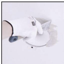
7. Nałóż gładź szpachlową (czas schnięcia wg zaleceń producenta).
