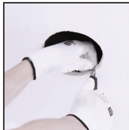
4. Wyczyść krawędzie otworu.
