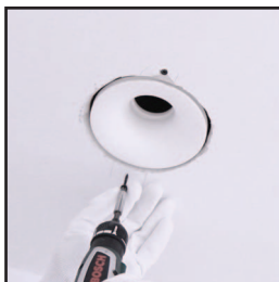
6. Wkręć wkręty w wyznaczone miejsce.
